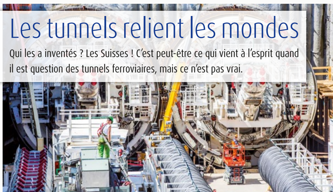
Deux machines à bouclier pour l'Albvorlandtunnel
