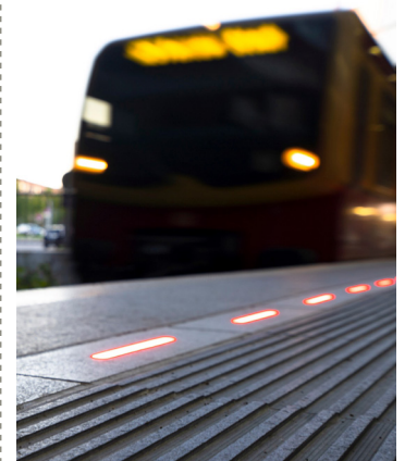
Bord de quai lumineux sur la voie 1 de la station Berlin Südkreuz
