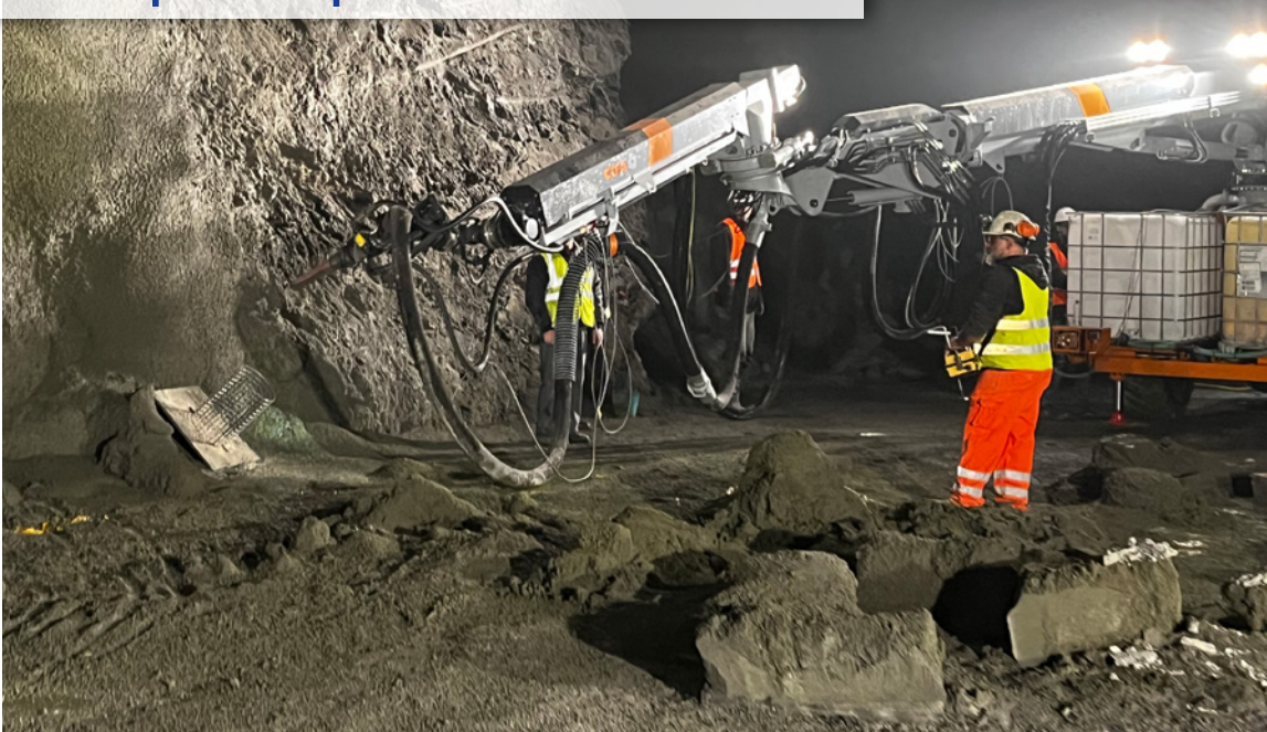
La pompe à béton projeté Mamba utilisée dans un tunnel
