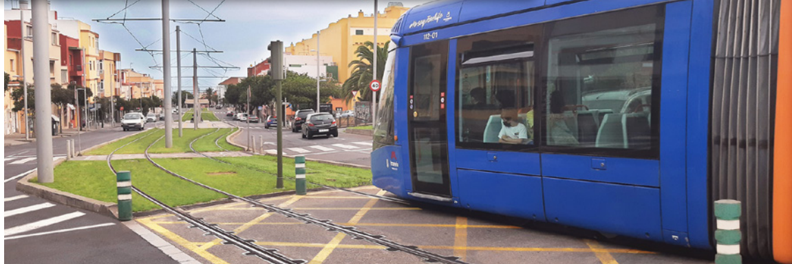
Le tramway de Ténériffe circule sur des rails dans la gaine d'isolation amovible
