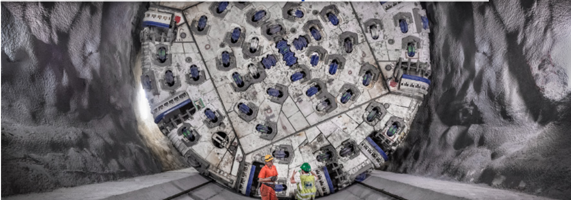
Début des travaux de percement du tunnel de base du Brenner
