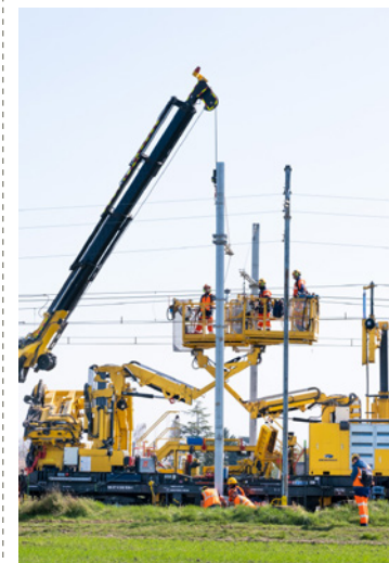
Le train TSG rénove les caténaires du réseau 1 500 volts
